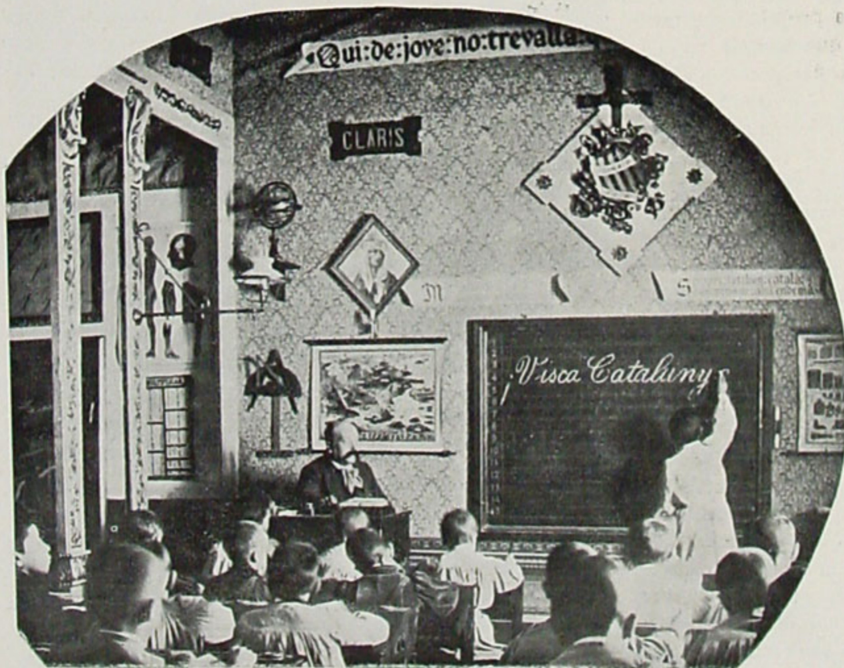
COL·LEGI DE SANT JORDI: VISTA DE LA SALA ELEMENTAL.
