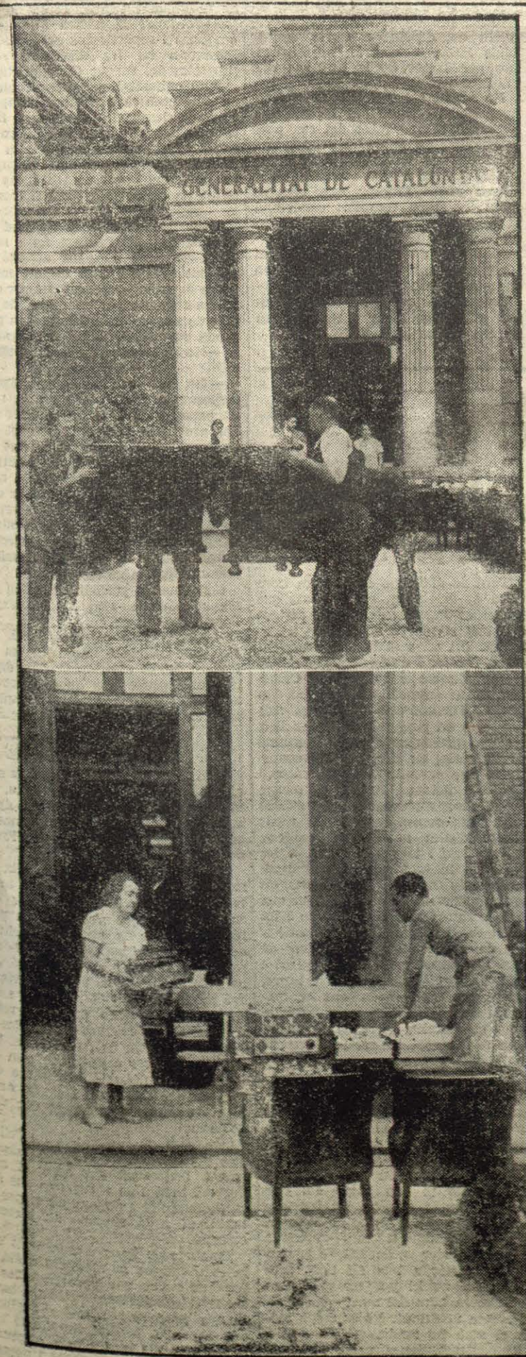
Aquest matí ha començat el trasllat al Palau del Parlament de la Conselleria de Justícia i Dret, instal·lada a l'edifici especial del Parc de la Ciutadella per l'ex-conseller Pere Comes. En aquesta instal·lació, que com es veu a les fotos, s'està desfent, foren invertides tres-cents mil pessetes... (Foto Sagarra)
